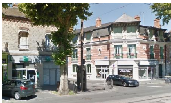
Des ensembles bâtis patrimoniaux - Source : Google Street View
