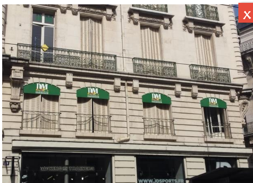
Implantation d'enseignes en façade peu judicieuses et altérant la façade patrimoniale du bâtiment
