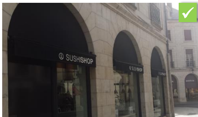
Enseignes discrètes aux teintes sobres, s'inscrivant dans les lignes architecturales du bâtiment
