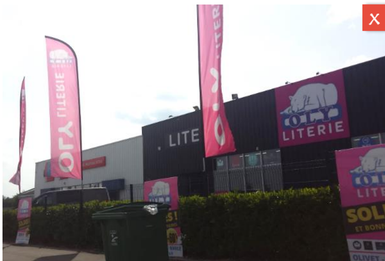
Non conforme : 1 enseigne au sol de + de 1m 2 max (ici les drapeaux)
