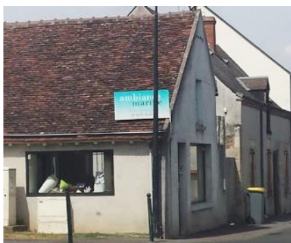
Non conforme : Enseigne en toiture en lettres non découpées
