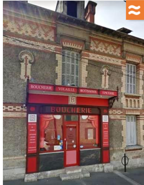
Des enseignes et traitement de devanture pouvant dénoter avec la façade de bâtiments à caractère patrimonial
