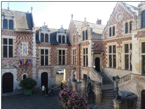
Figure 40 : L'Hôtel Grosloot d'Orléans, classé au titre des monuments historiques depuis 1862 (source : Biotope, 2018)
