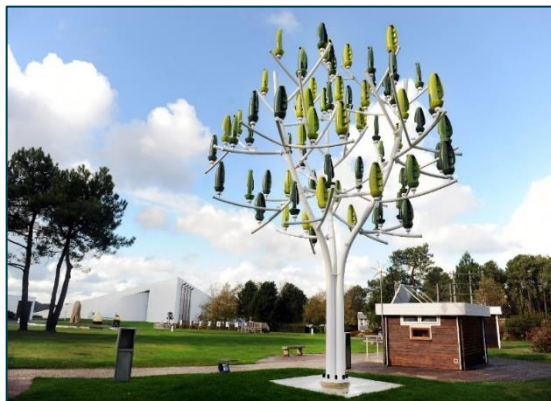
Figure 20 : Exemple d'éolienne domestique innovante, « l'arbre à vent » (source : AFP, 2014)
