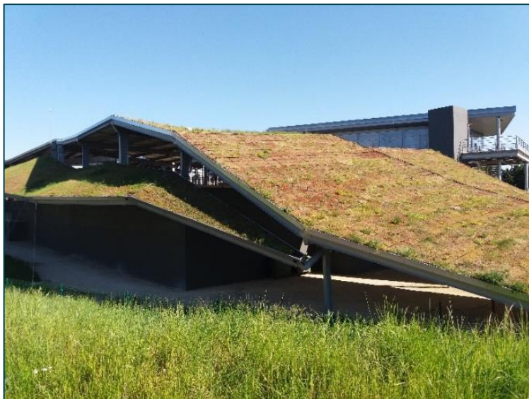
Figure 6 : Station d'épuration de l'Île Arrault à Orléans (source : Biotope, 2017)
