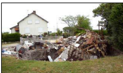
Figure 68 Effondrement lié à une cavité, (source : DDT 45)
