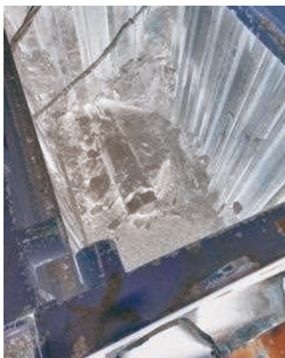
SARAN – Rue de Montaran : création d'un forage sous voie SNCF pour dévoiement d'un réseau d'eaux usées
