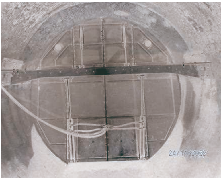
Photo d'une vanne mise en place
