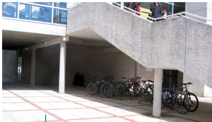
Stationnement sous l'entrée de la faculté des Lettres, langues et sciences humaines. Source : AUAO
